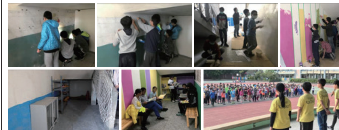
小組美力行動＜閱讀角＞：樓梯間牆面刮除、批土、油漆、書籍上架、進行全校宣導
